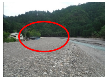
家屋の1階の高さまで土砂が堆積 降雨のたびに浸水被害の発生を危惧 (平成25年9月: 県職員撮影)
